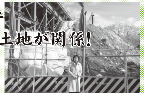
膨大な産廃が不法投棄された現場
