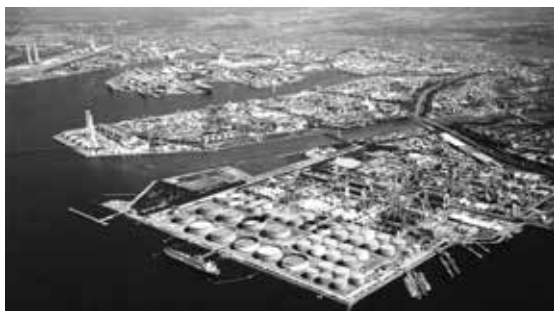
京葉コンビナートには石油タンク 1,000 kℓ以上 863 基、1,000 kℓ未満は 2,200 基、その他ガスタンクが 396 基、プラント等が 642 施設あります
