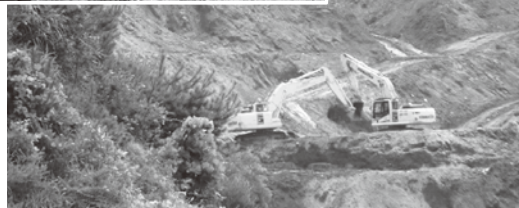
新たな巨大な再生土埋め立て中の現場(鶴舞)
